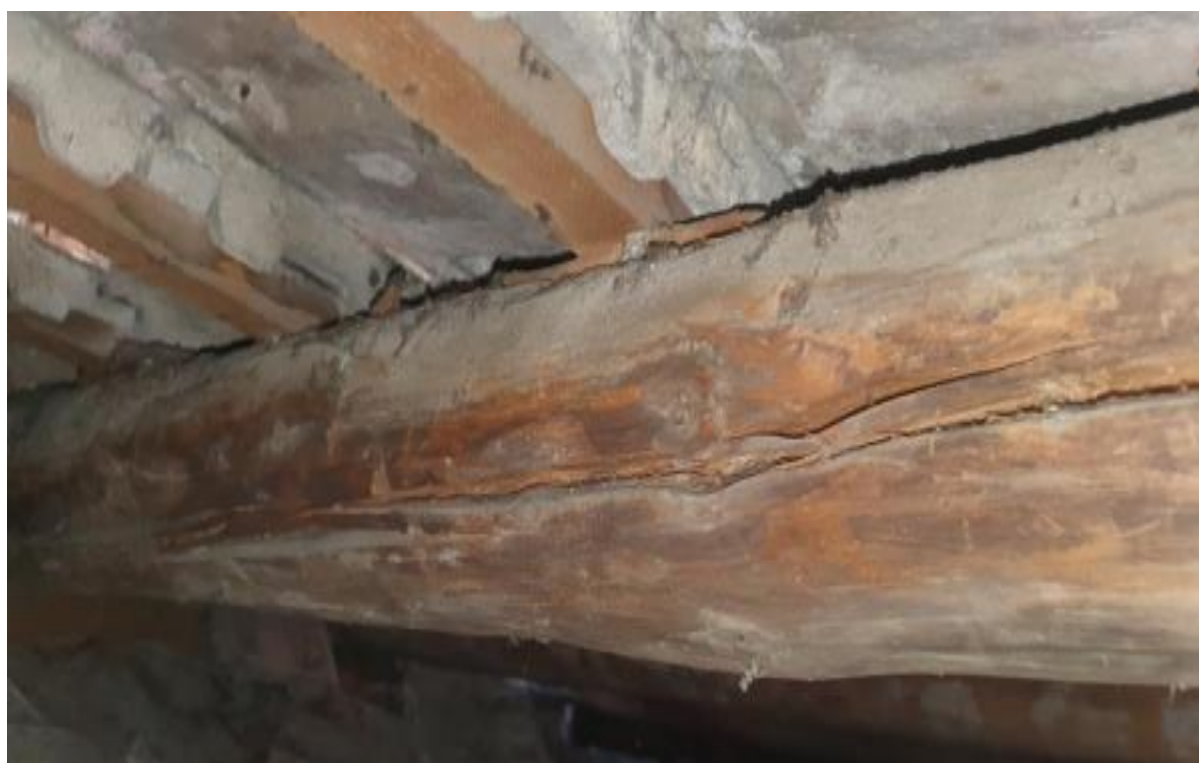
Slika 8. Napukla nosiva greda krovišta 2
