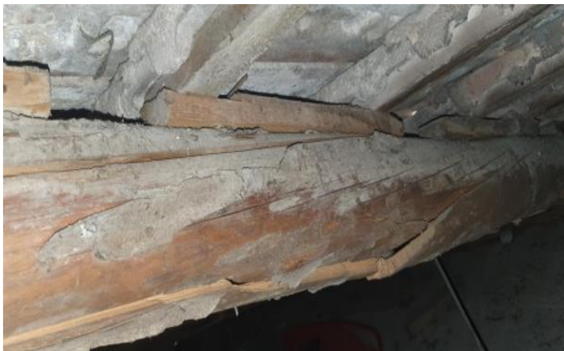
Slika 7. Napukla nosiva greda krovišta zbog čega prijeti urušavanje istog
