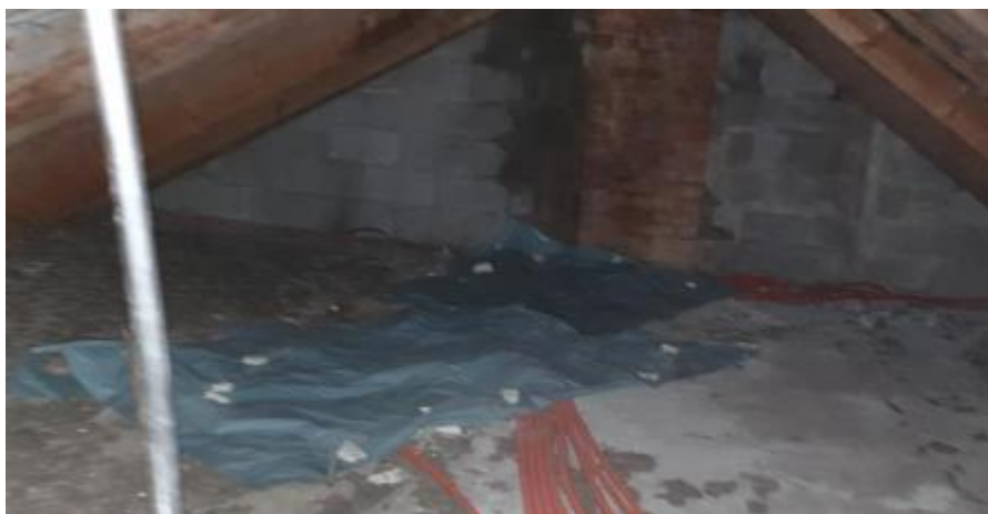
Slika 9. Prodiranje kiše po bočnom zidu krovišta uslijed pucanja crijepa (podna podloga nije betonska nego od trstike i granulata zbog čega je porozna i voda lako prolazi kroz istu zbog čega je ista i oštećena)
