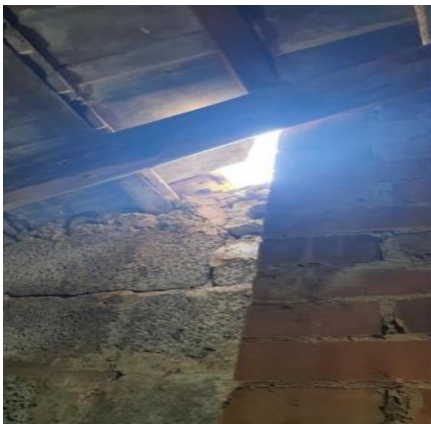
Slika 10. Oštećenje krovišta koje dovodi do slijevanja vode po zidu (slika 9.)
