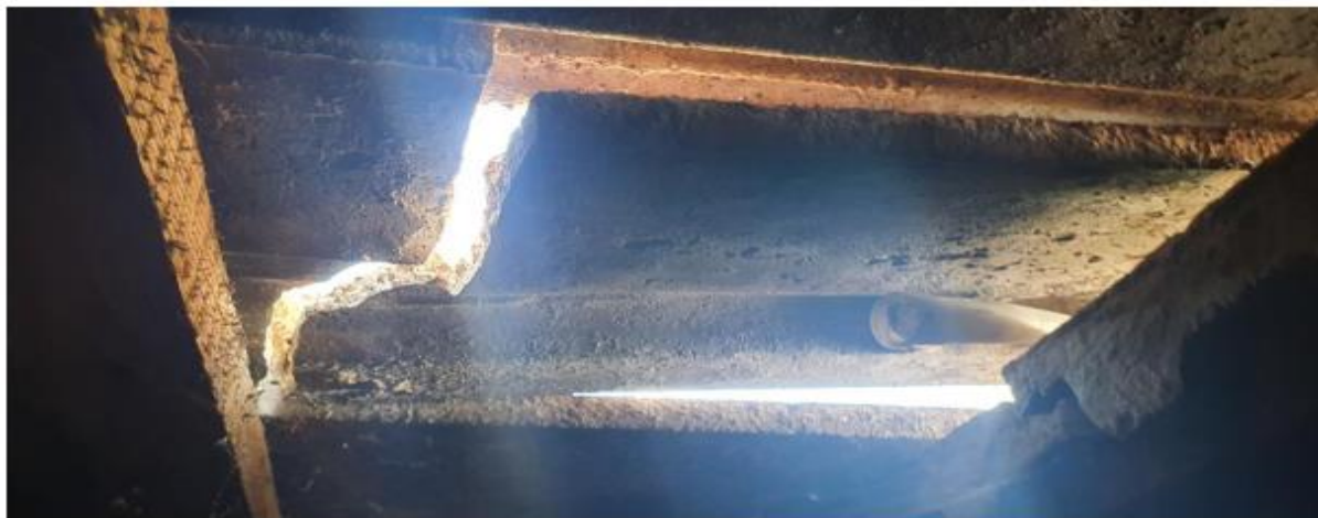
Slika 4. Puknuće crijepa na krovištu
